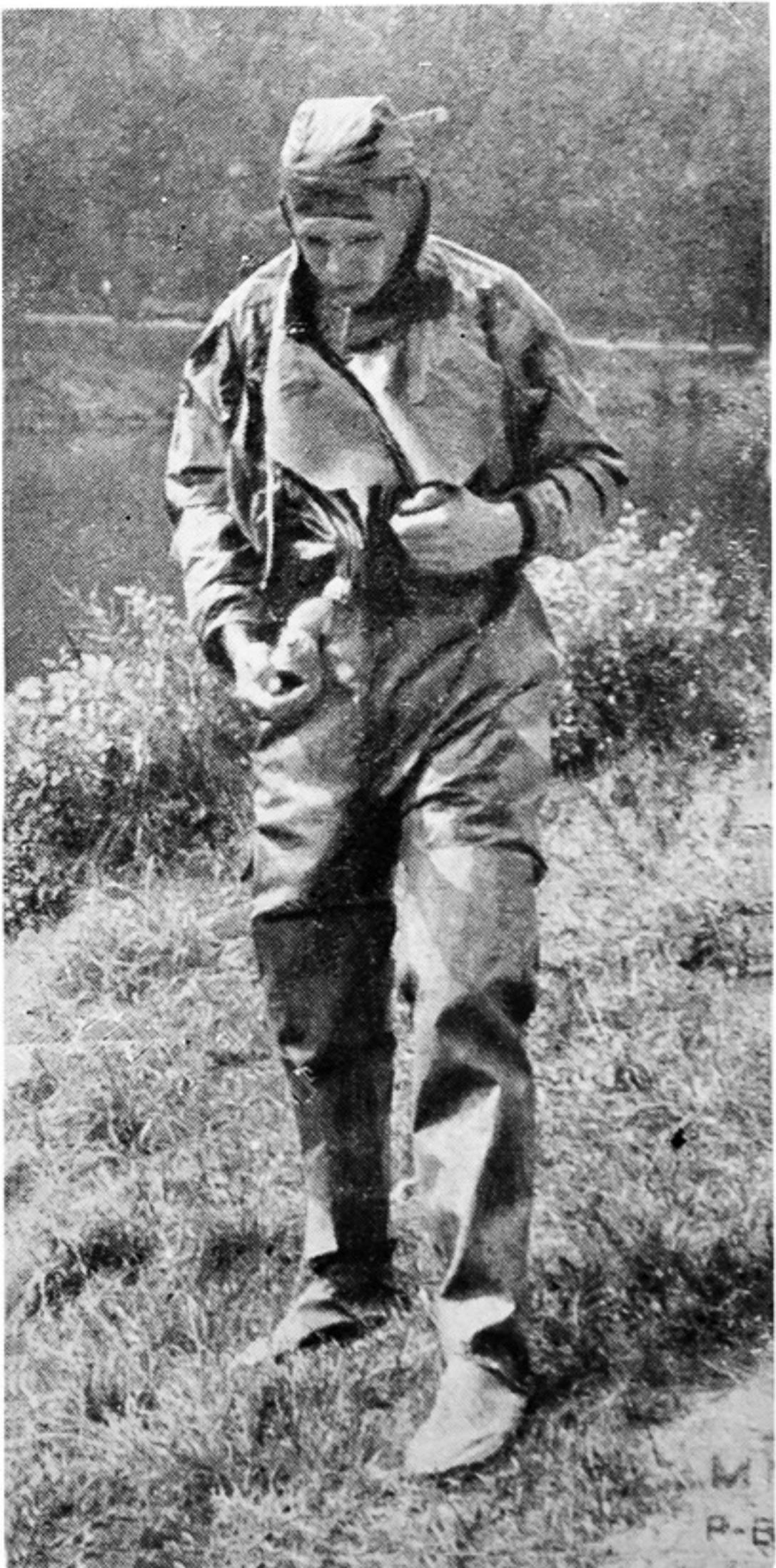
Obr. 26. Potápěč v plovacím potápěčském obleku PPO - utěsnění oblékacího nástavce
