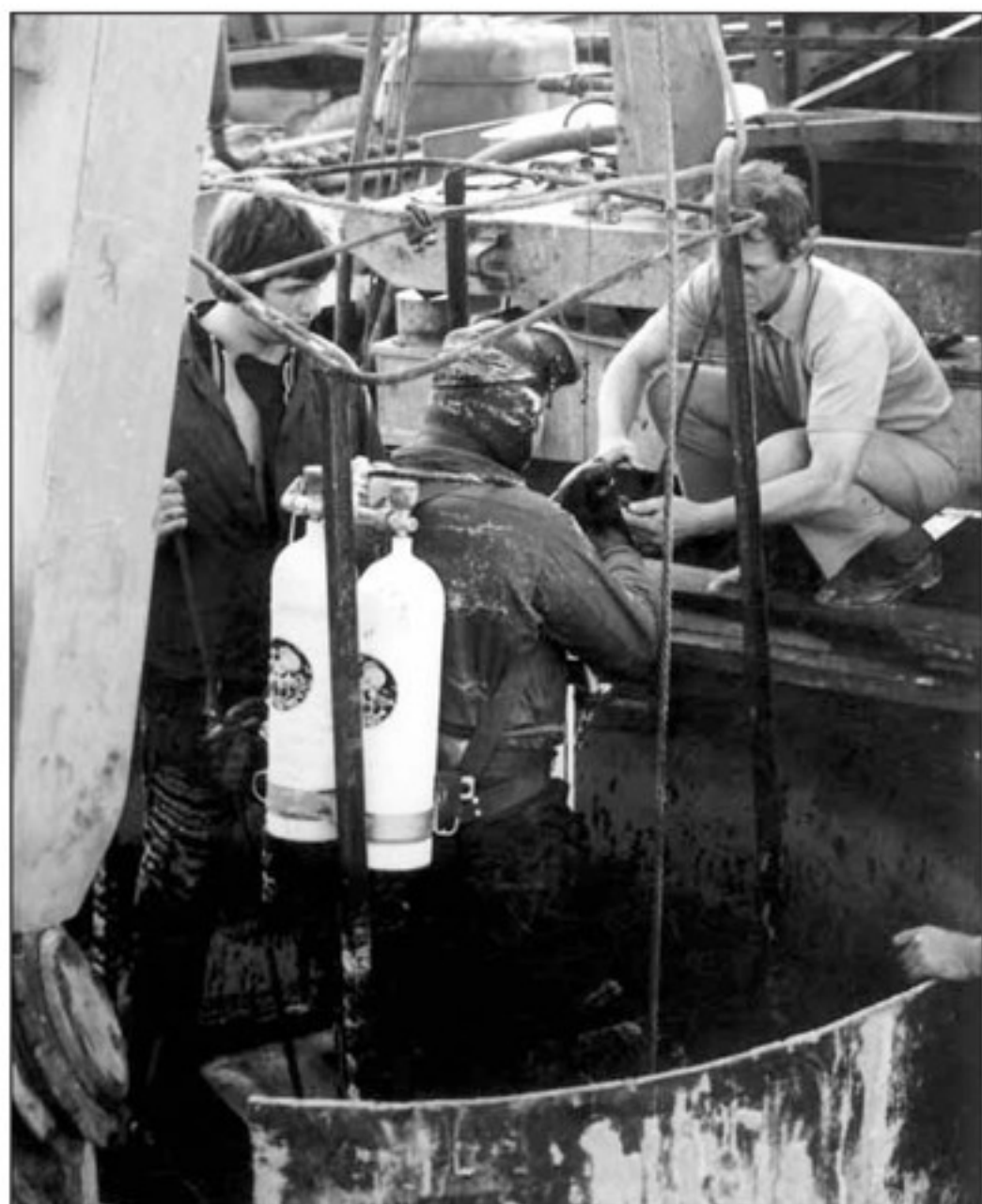
Záchrana vrtacího zařízení, stoka K-Barandov 1982. Na snímku vlevo zleva první Pavel Bruk a druhý potápěč Jaroslav Vaněček. Vpravo okruží průměr 3 metry, hloubka 42 metrů
