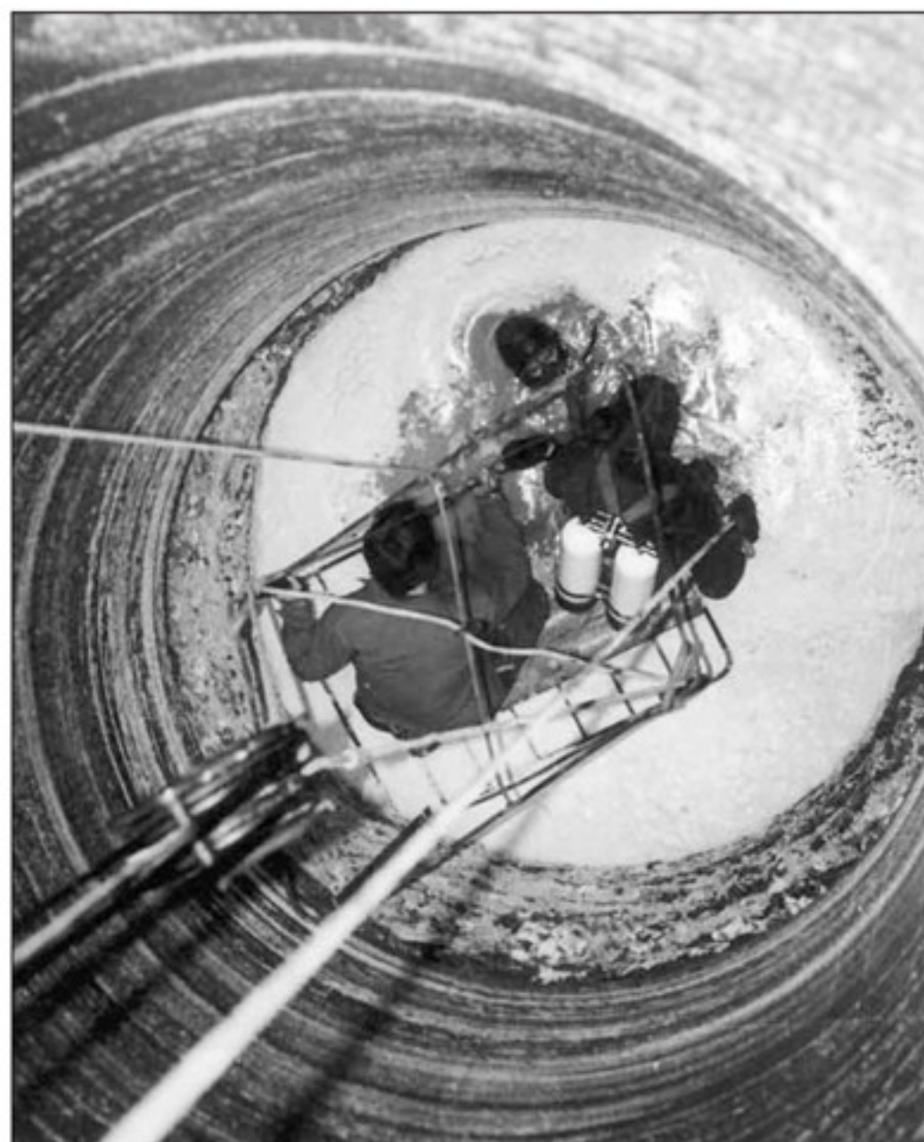
Záchrana vrtacího zařízení, stoka K-Barandov 1982. Na snímku vlevo zleva první Pavel Bruk a druhý potápěč Jaroslav Vaněček. Vpravo okruží průměr 3 metry, hloubka 42 metrů
